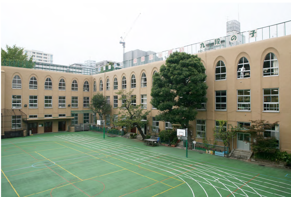
2. 校庭側立面：窓高が統一された立面（右校舎：普通教室、左校舎：廊下）撮影：山崎鯛介
