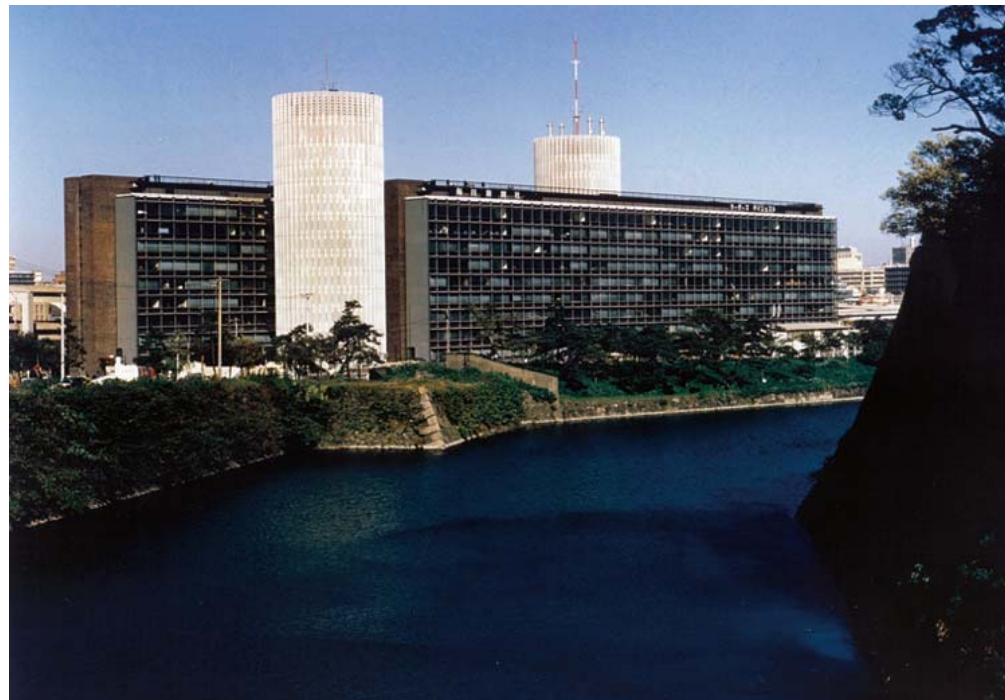
パレスサイドビル 昭和41年(1966) 日建設計HPより
