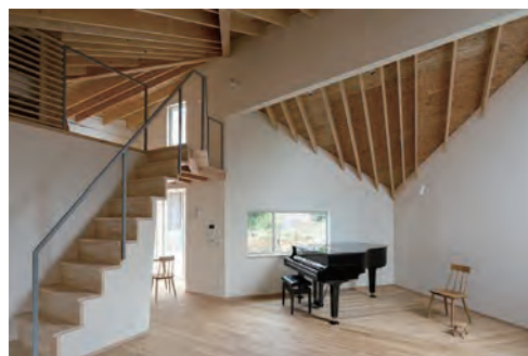
構造表しで垂木をランダムに配置した内部演奏空間
