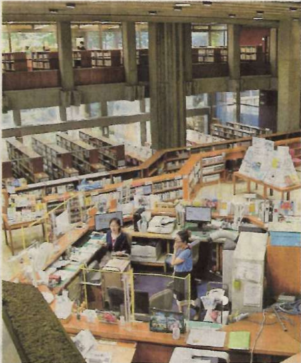
日本大学図書館生産工學部分館の内部。奥の上階は小さい柱で吊り下げられている構造。受け付けカウンターのある手前部分の床は下部にある柱で支えられている
