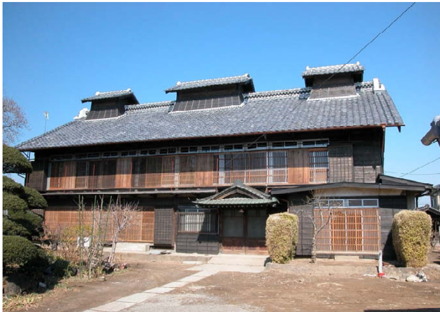
小茂田家住宅再生後外観
