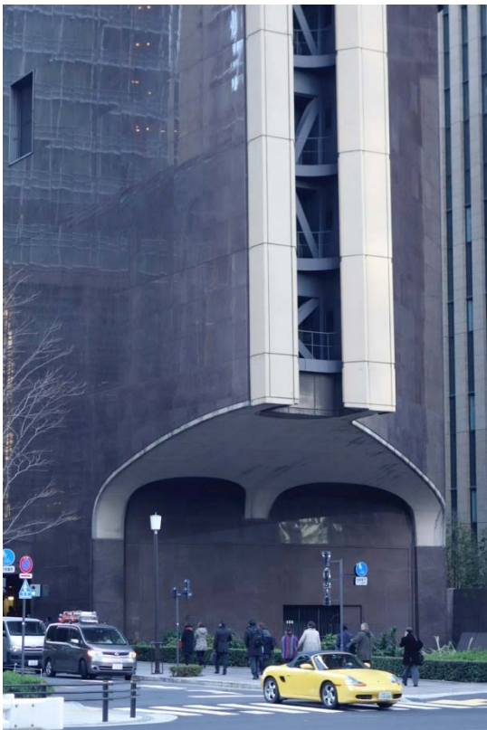
北側（設備ダクトスペース）
