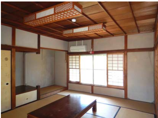
サンルーム棟内部 10畳座敷の琵琶床と肘掛窓をみる
