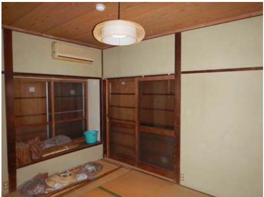
居間棟内部 6畳間の出窓と掃き出し部をみる
