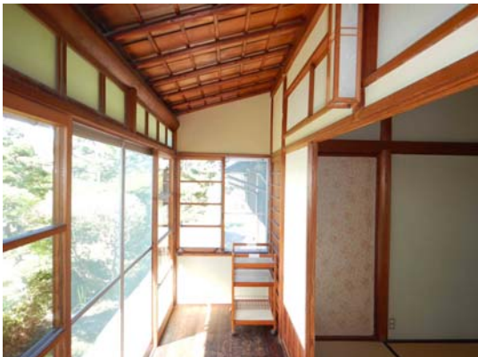
増築棟内部 南縁
