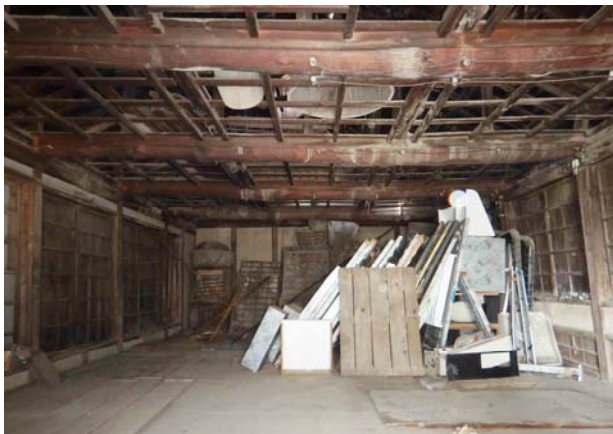
蚕室2階内部 東から西を見る
