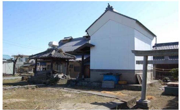
屋敷背面 種蔵跡・井戸上屋・主屋・文庫蔵・屋敷神
