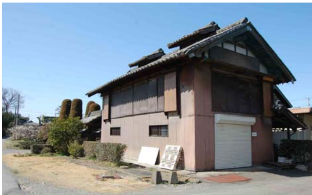
蚕室南面・東側面全景 東側面のシャッターは後設
