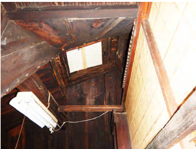
主屋(居室部) ナカノマ奥室南土間部の屋根裏
