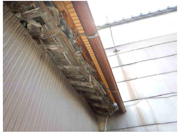
主屋(居室部) 屋根軒裏見上げ(北西隅)
