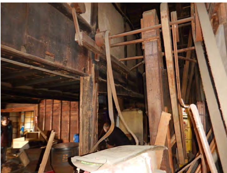
主屋(店部) 北妻側増築部前端から内部を見る
