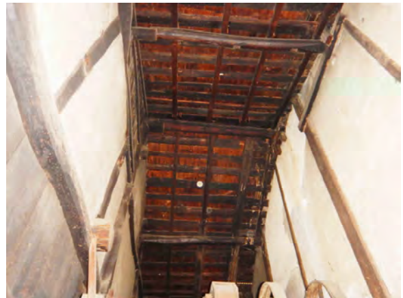
主屋(店部) 北妻増築部屋根裏見上げ
