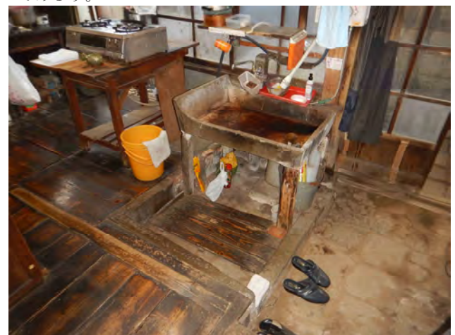
主屋居室部と背面突出部との境
