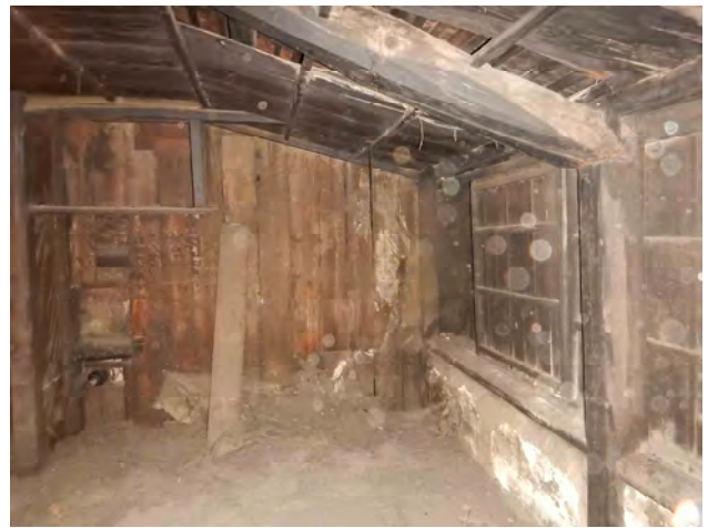
主屋(店部) 中2階正面と北妻面を見る
