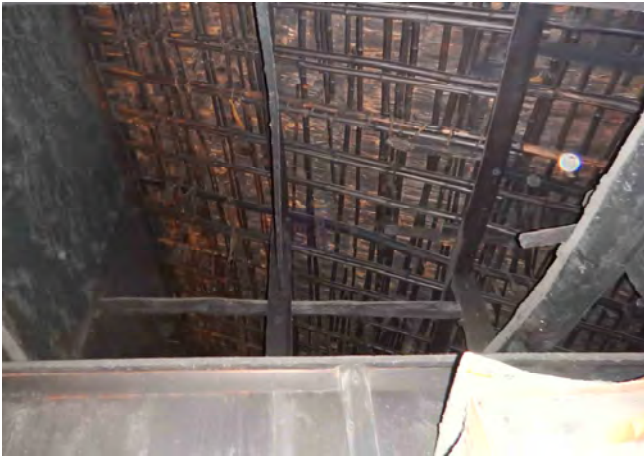
主屋(居室部) 屋根裏見上げ
