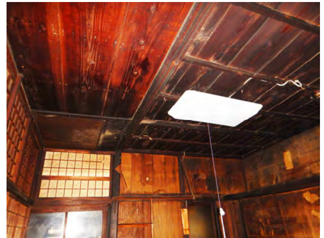
主屋(居室部) 南列奥室
