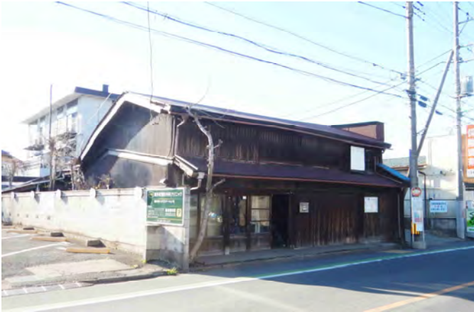
主屋(店部) 正側面全景
