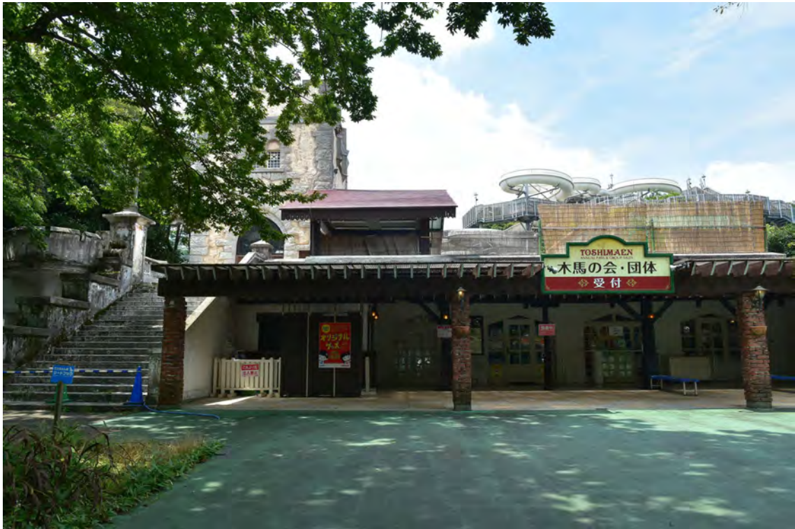
9 東側外観 現状写真
