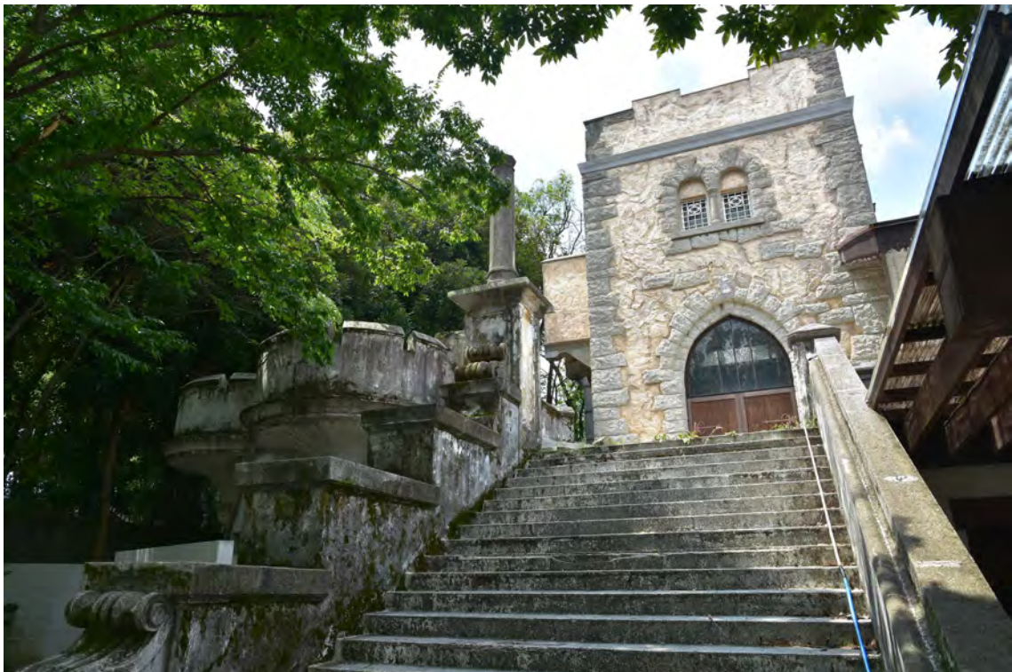
10 塔と大階段 現状写真
